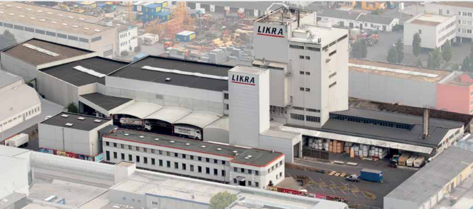
Unternehmenszentrale LIKRA Tierernährung, Produktionsstandort Linz Group Headquarters LIKRA Tierernährung, production site Linz
